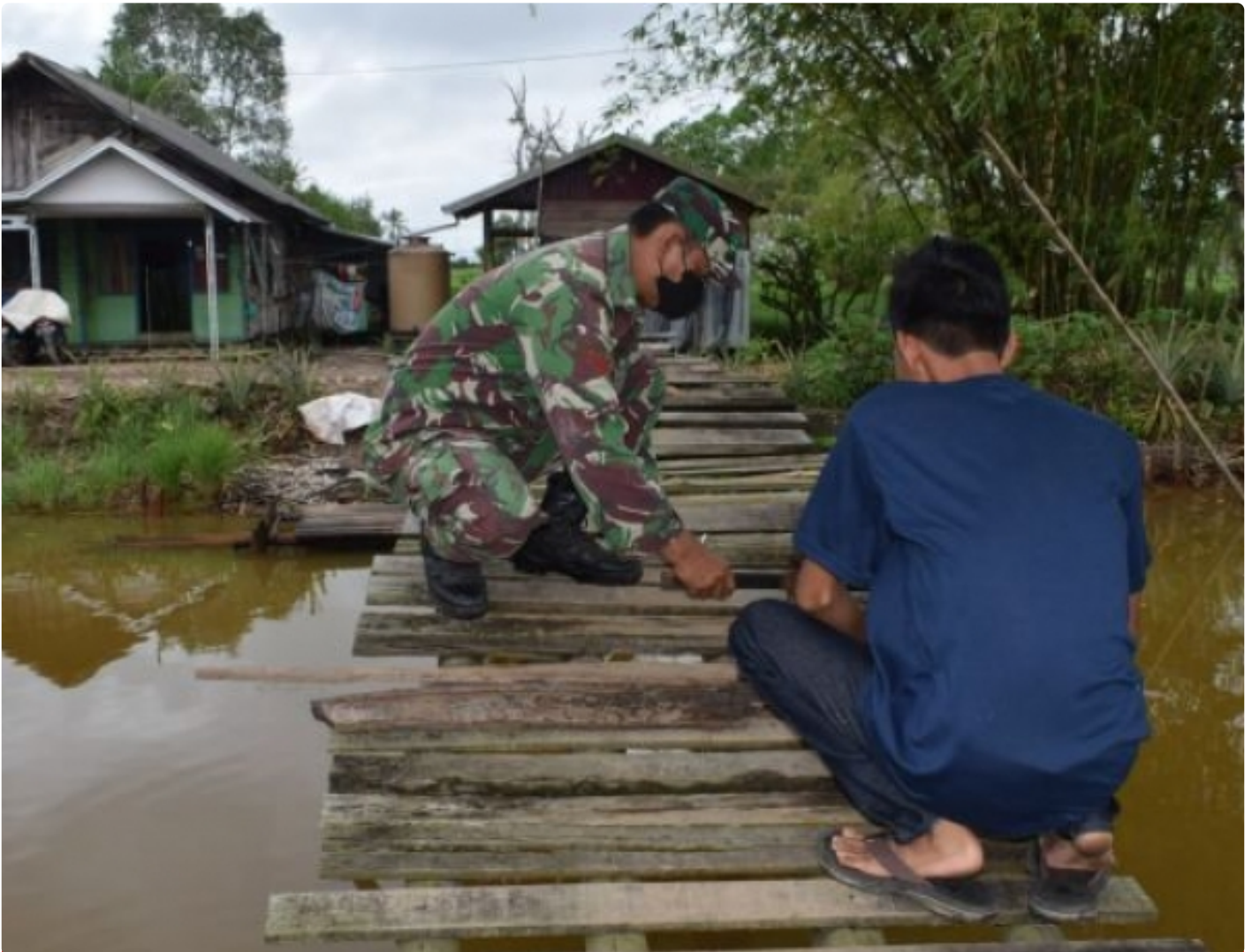
Babinsa Kodim 1005/Barito Kuala Bantu Perbaikan Jembatan
